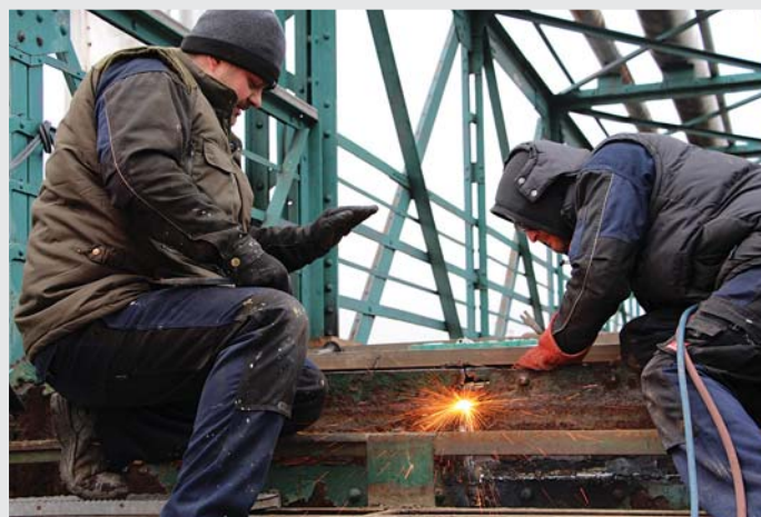
Specializovaná firma v úterý 27. března opravila jednu z opěr scho-diště lávky pro pěší přes železniční trať u vlakového nádraží. Ta proto byla na jeden den uzavřena a pěší museli chodit přes sousední most. Ocelová nýtovaná lávka byla postavena v roce 1909 a město v současnosti připravuje její celkovou rekonstrukci. Foto: Dita Círová
