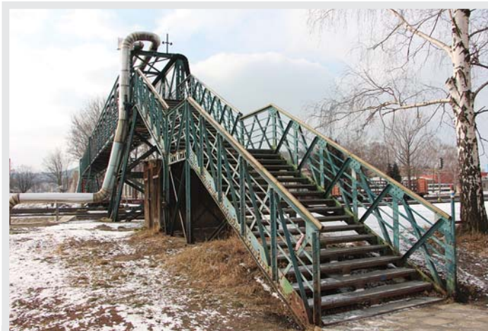
Firma provede výměnu horní příčle krajní rámové podpěry, která se nachází na konci schodiště ve směru od ulice Nádražní.
