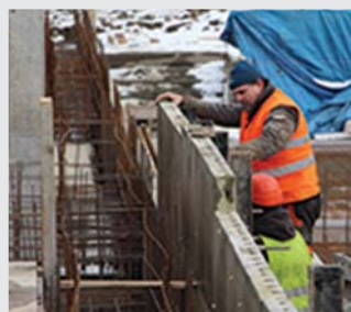
Minulý týden na koupališti probíhala mimo jiné montáž výztuže stěn bazénu.
