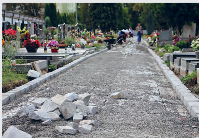
Po loňské výstavbě vodovodu město pokračuje ve zvelebování hřbitova. Hotové jsou už první metry nového obvodového chodníku, který bude kompletně dokončen v říjnu. První etapa rekonstrukce hřbitovních cest přijde na necelé čtyři miliony korun. Foto: Tomáš Gaudek
