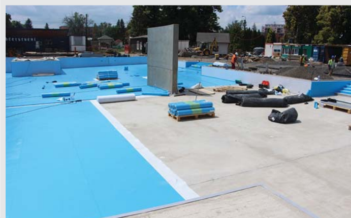
Bazény na koupališti se zbarvují do modra. Tuto barvu má speciální bazénová fólie, již odborníci potahují stěny i dna bazénů. Foto: Dita Círová
