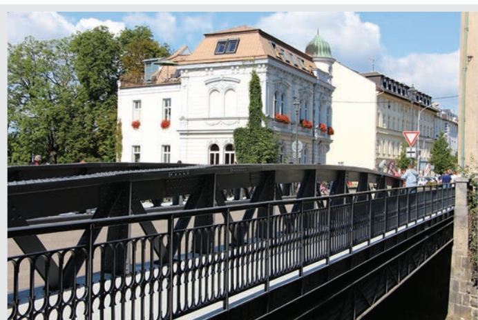
Byla dokončena rekonstrukce historického mostu přes řeku Opavu, včetně komunikace, chodníků, osvětlení a limnigrafické stanice.
