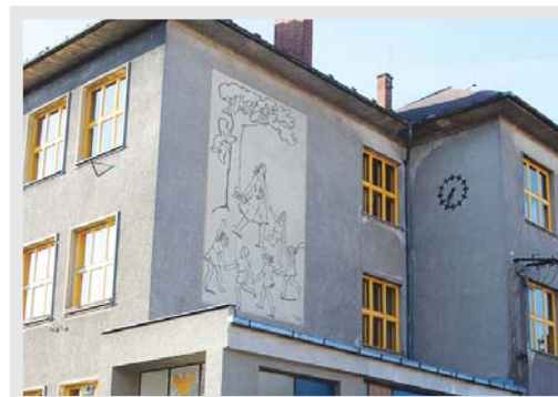
SPgŠ a SZŠ Krnov měla kvůli zateplení fasády přijít o umělecké dílo Jindřicha Bajgara.
