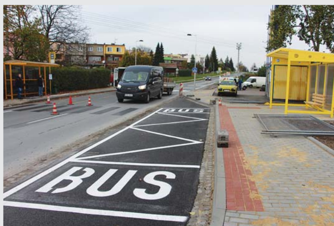
Nový záliv u zastávky MHD Krnov, Partyzánů Depo, a také přesun přechodu pro chodce a jeho nasvětlení zlepšil bezpečnost osob, které se v tomto prostoru pohybují.
