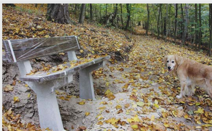
V zalesněné části Cvilína nad Petrovým dolem dochází k obnově výletní pěšiny. Její součástí je také instalace nových laviček.
