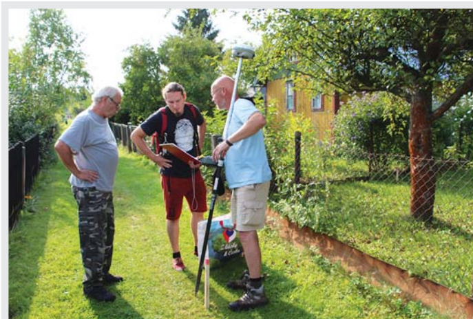
V zahrádkářské osadě Zlatá Opavice v pátek 25. srpna proběhlo přesné vytyčení záboru pozemků pro potřeby stavby obchvatu.
