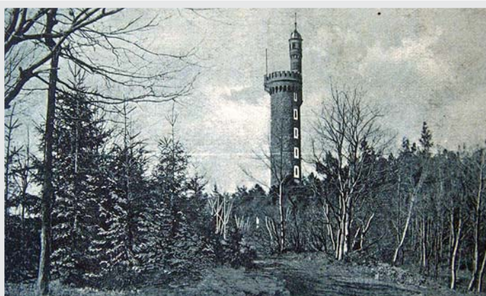
Cvilínská rozhledna byla vybudována v letech 1902-1903. Cimbuří završovala patrová věžka, jejíž patrová část v současnosti chybí.
