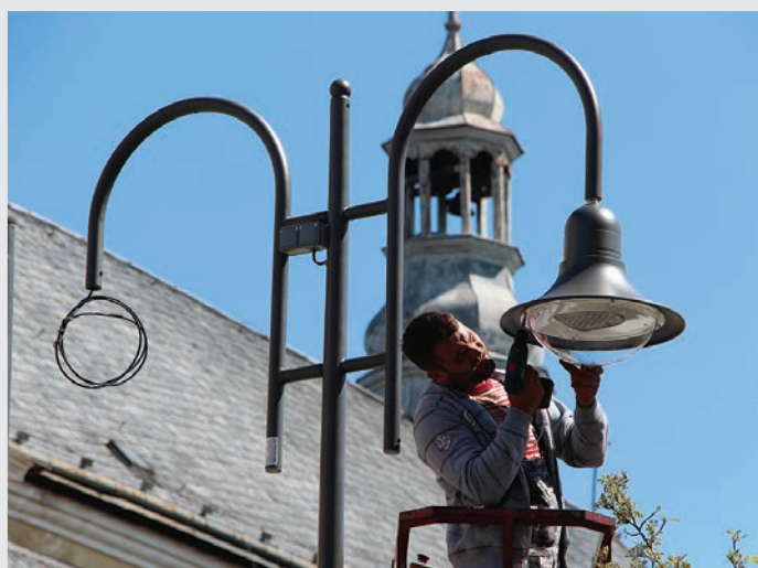
Montáž nových LED svítidel na náměstí Minoritů.
