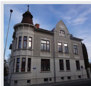
Budova MŠ Svatováclavská.
