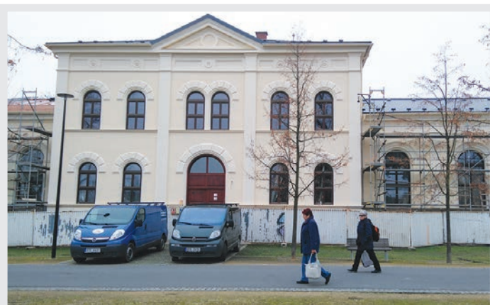
Tělocvična u ZŠ na Smetanově okruhu prochází rekonstrukcí.
