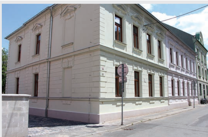
Zdevastované domy ve Staré ulici se díky rekonstrukci změnilý k nepoznání.
