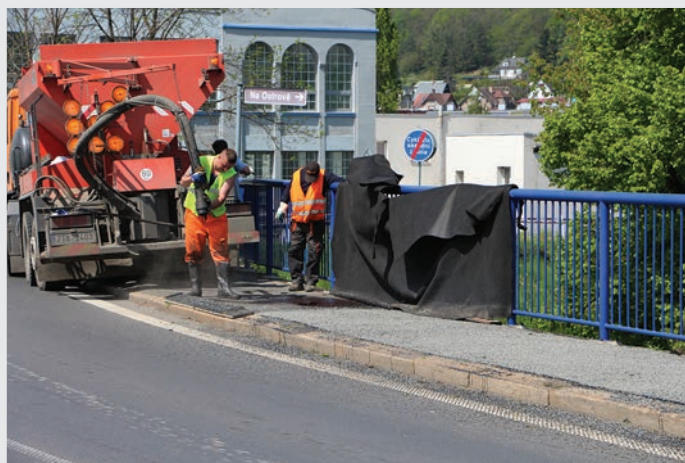
Ředitelství silnic a dálnic ČR provizorně opravilo chodníky na mostě přes železniční trať u hlavního nádraží. Rekonstrukce celého mostu proběhne pravděpodobně příští rok.
