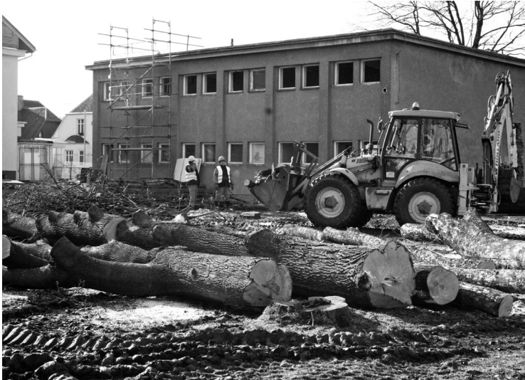
U základní školy na Janáčkově náměstí bylo 25. února vykácano dvanáct stromů podél ulice Seifertova. Jejich odstranění společně s následnou demolicí gymnastického sálu stojí na začátku výstavby školní tělocvičny za 45 milionů korun. Ta bude zárukou k dispozici již ve školním roce 2013/2014.
