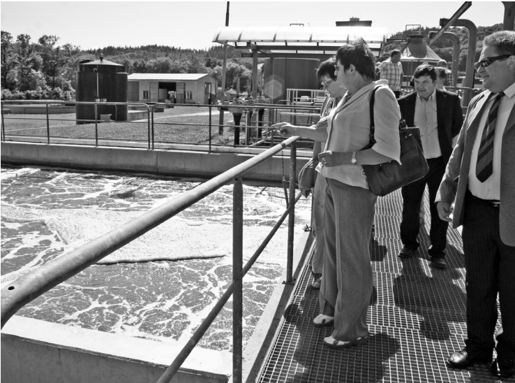
V loňském roce město dokončilo jednu z největších investičních akcí posledních let - rekonstrukci a intenzifikaci čistírny odpadních vod, která stála 191 milion korun.
