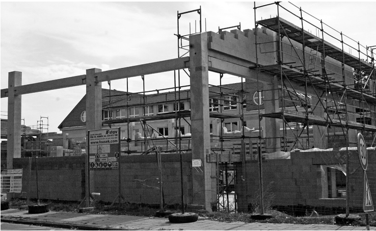
Výstavba tělocvičny u základní školy na Janáčkově náměstí pokračuje podle časového harmonogramu.
