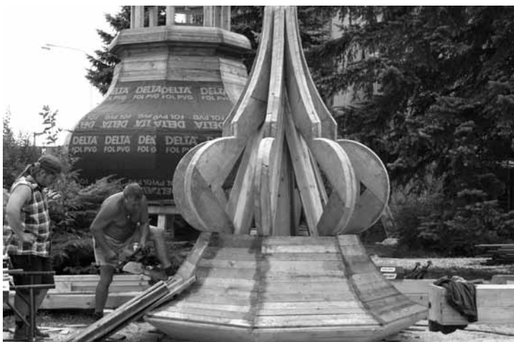
Kostel sv. Benedikta v Kostelci v těchto dnech získává novou střechu.
