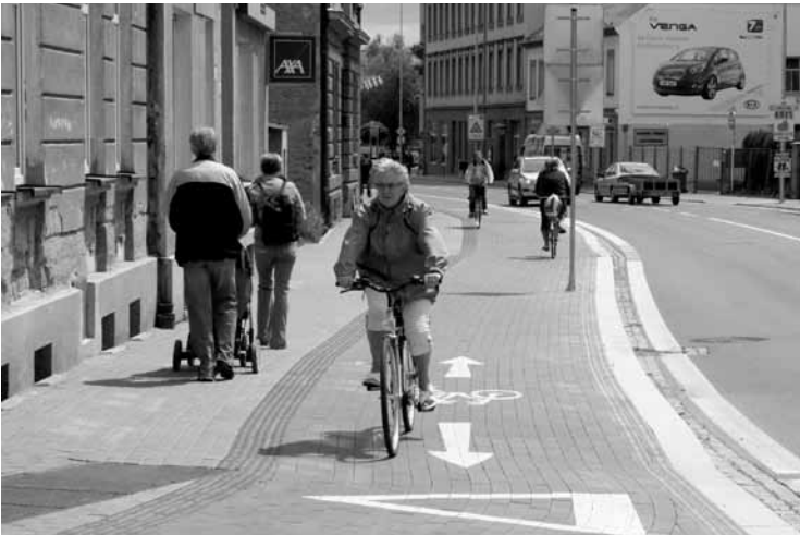
Na Opavské ulici, v úseku od ulice Stará po ulici 9. května se klasický chodník proměnil ve společnou dělenou stezku, kdy pro cyklisty je určen červeně dlážděný pruh s výrazným dopravním značením a pro chodce pruh dlážděný šedou zámkovou dlažbou.
