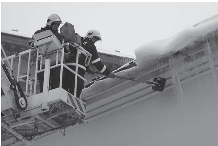
Hasiči každý den odstraňují sníh a led ze střech. Na snímku při zásahu na budově tělocvičny základní školy na Smetanově okruhu ve středu 13. ledna.
