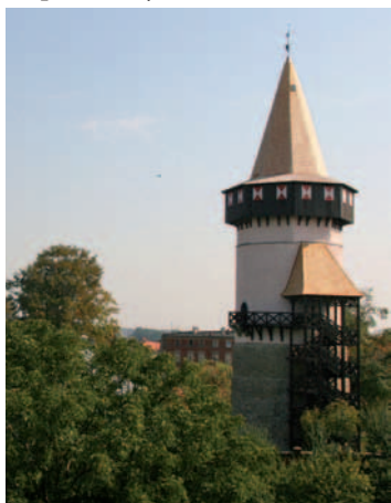
Prudnický zámek vyhořel v roce 1806 a jeho zbytky, kromě jediné věže, byly rozebrány. Horní část věže byla nyní obnovena.
