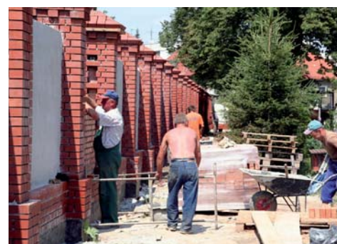
Výstavba hřbitovní zdi na ulici Grunwaldzka.
