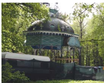
V městském parku v Prudniku probíhá rekonstrukce hudebního pavilonu.
