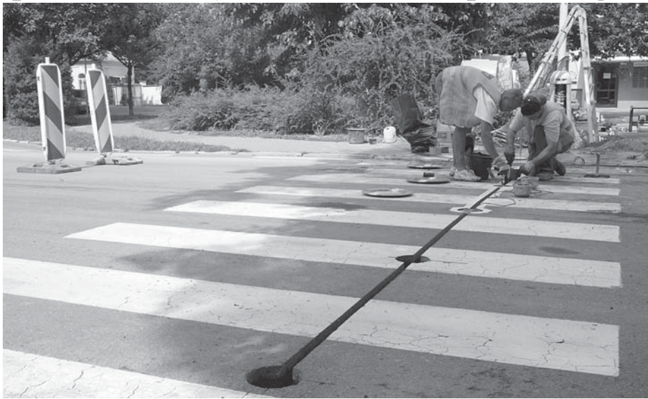
Světla, která čtyřiačtyřicet hodin blikají na přechodu pro chodce před základní školou na Dvořákově okruhu, jsou zapuštěna do vozovky.
