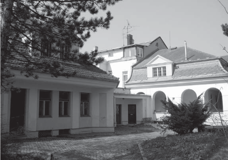
Součástí areálu Flemmichovy vily je také hospodářská budova (na snímku), skleník a pozemky s okrasnou zahradou, dvěmi funkčními kašnami, sadovou částí a užitkovou zahradou.
