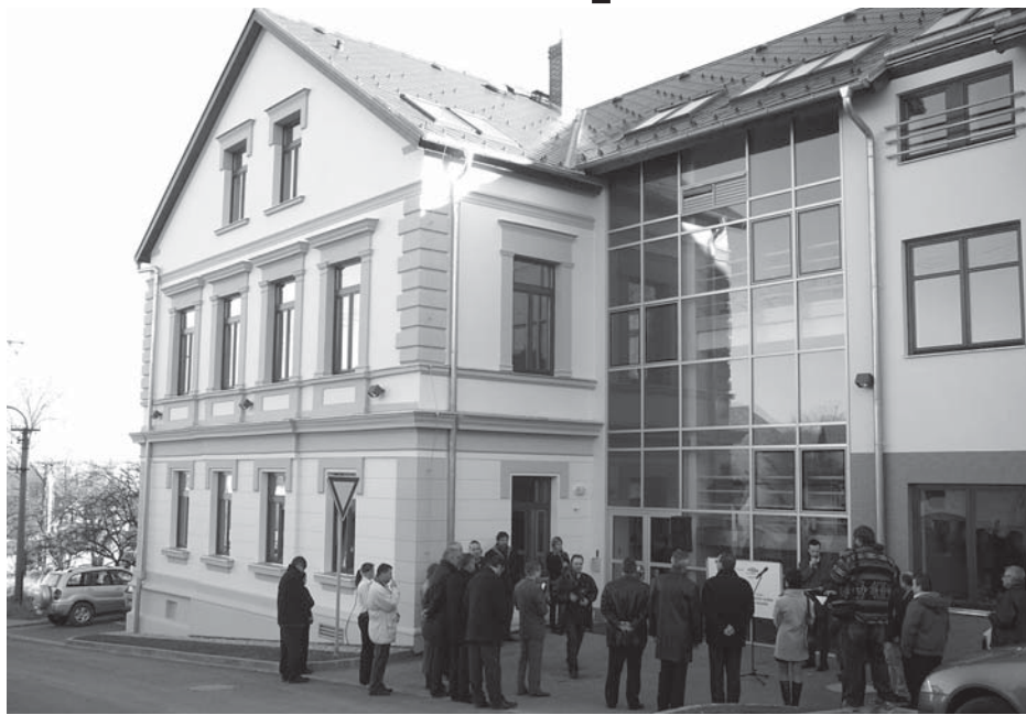
Z bývalé základní školy na Chářovské ulici je Centrum rezidenčních služeb pro mentálně postižené dospělé.
