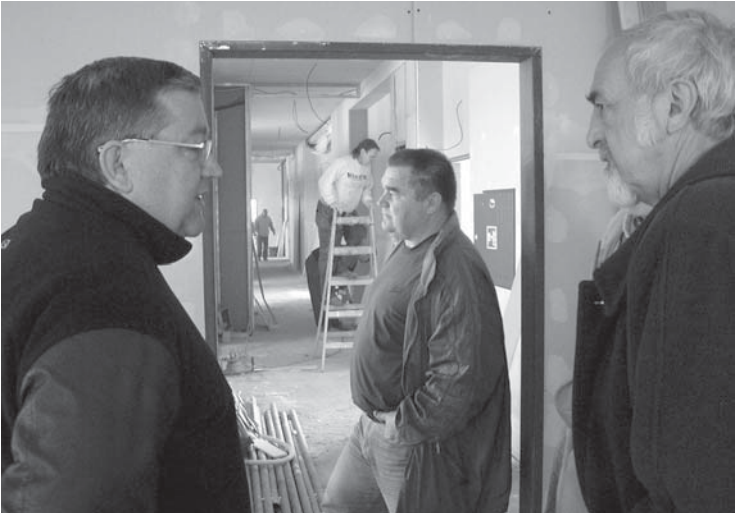
Pavilon „B“ Základní školy na Janáčkově náměstí v současné době prochází zásadní rekonstrukcí. Jakým způsobem přestavba probíhá, zjišťoval minulý týden na místě starosta Josef Hercig, vlevo Libor Nowak z firmy Stafi CZ, s.r.o., která pavilon opravuje.
