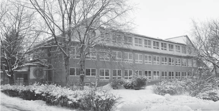
K investičně náročným akcím letošního roku patří I. etapa rekonstrukce Základní školy na Janáčkově náměstí.
