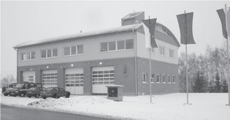
Nová hasičská zbrojnice na Partyzánské ulici slouží od konce loňského roku hasičům.
