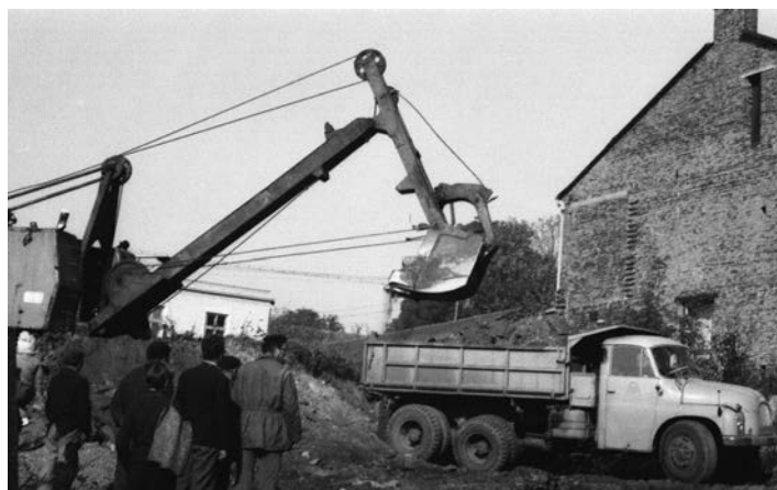
První výkopy stavby nové samoobsluhy na ulici Družební, r. 1972
