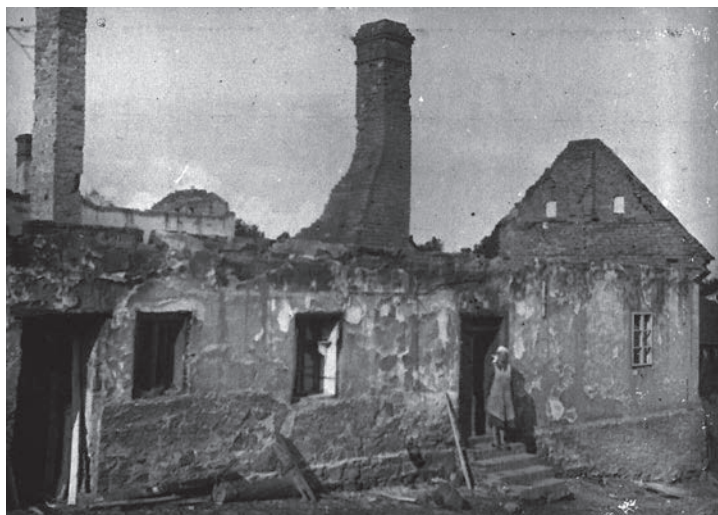
Selská usedlost č.p.10, p. Karel Kotla v roce 1945 na ul. Družební
