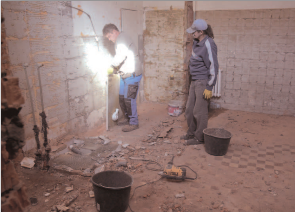
Sociální zařízení ve druhém patře na zimním stadionu procházejí rekonstrukcí. Ta by měla skončit na konci března. FOTO: DAVID MACHÁČEK
