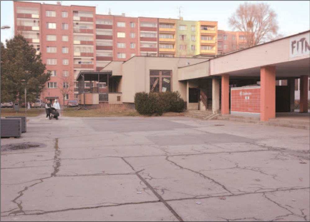
Část veřejného prostoru na sídlišti Sever, jeho nová podoba je předmětem vyhlášené soutěže. Realizace vítězného návrhu se má vejít do limitu 25 milionů korun bez DPH. FOTO: DAVID MACHÁČEK
