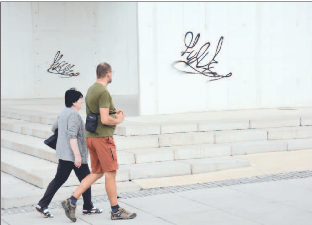
Sprejer se v noci na neděli podepsal na pilířích Lašské brány. Věc řeší policie, ale odstranění nápisů by nemělo být problematické.
