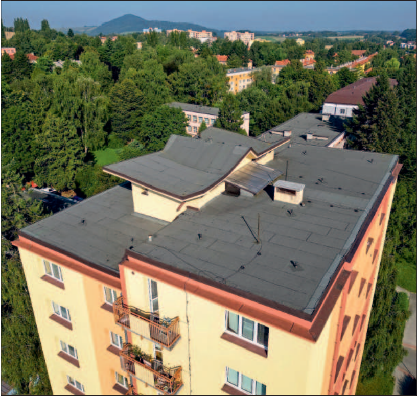
Celková rekonstrukce se dočká střecha domu na ulici Obránců míru č. p. 891, kterou má stavební firma dokončit do konce října. FOTO: MÚ KOPŘIVNICE
