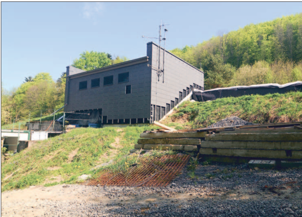
Vodojem na Červeném kameni prochází rozsáhlou rekonstrukcí. Hotovo má být letos na podzim.
