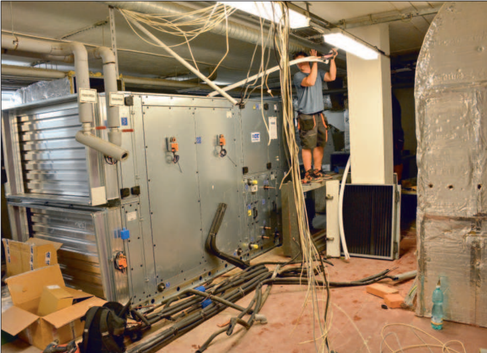
Pokračují práce na instalaci nové vzduchotechniky, která zajistí po svém spuštění větší komfort návštěvníkům kinosálu v kulturním domě. FOTO: DAVID MACHÁČEK
