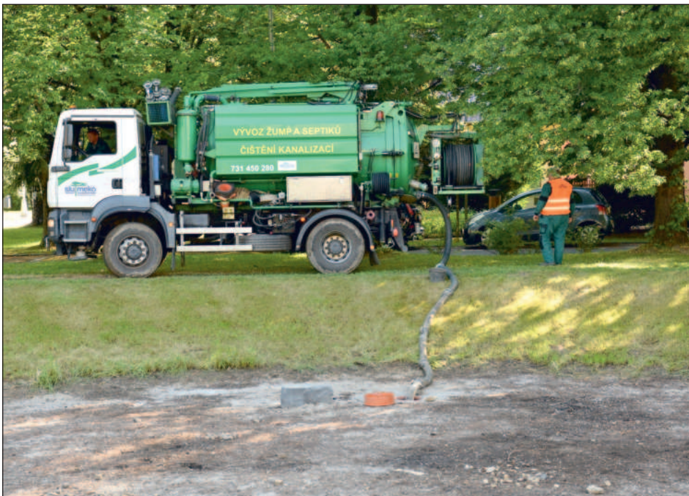
V minulém týdnu Slumeko čerpalo vodu nashromážděnou ve vsakovacím průlehu. Nyní se bude zjišťovat, zda do něj neprosakuje spodní voda.
