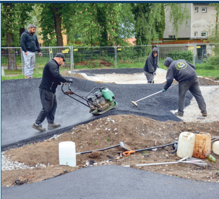
Pumptrack v areálu někdejšího házenkářského hřiště v minulém týdnu dostal asfaltový povrch.
