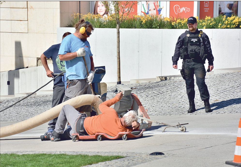
V minulém týdnu proběhla úprava vozových dráhek, které mají usnadnit pohyb slabozrakých a nevidomých lidí v rekonstruovaném centru města. FOTO: DAVID MACHÁČEK
