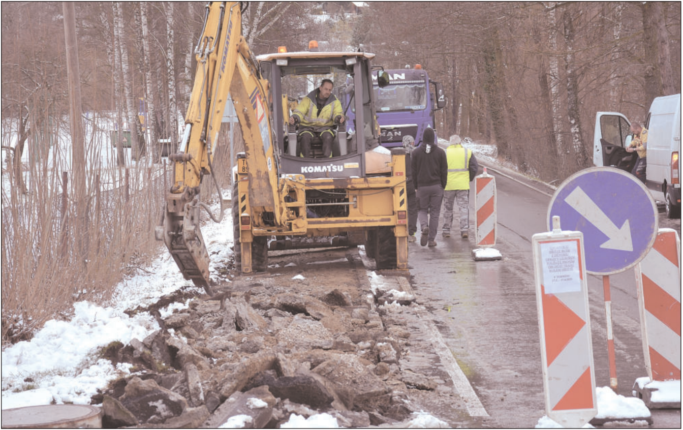
I přes sněhové přeháňky v pondělí začaly práce na rekonstrukci chodníku podél sportovního areálu v Lubině. Stavba bude komplikovat pohyb především chodcům, kteří nemají v místě k dispozici jiný chodník.
