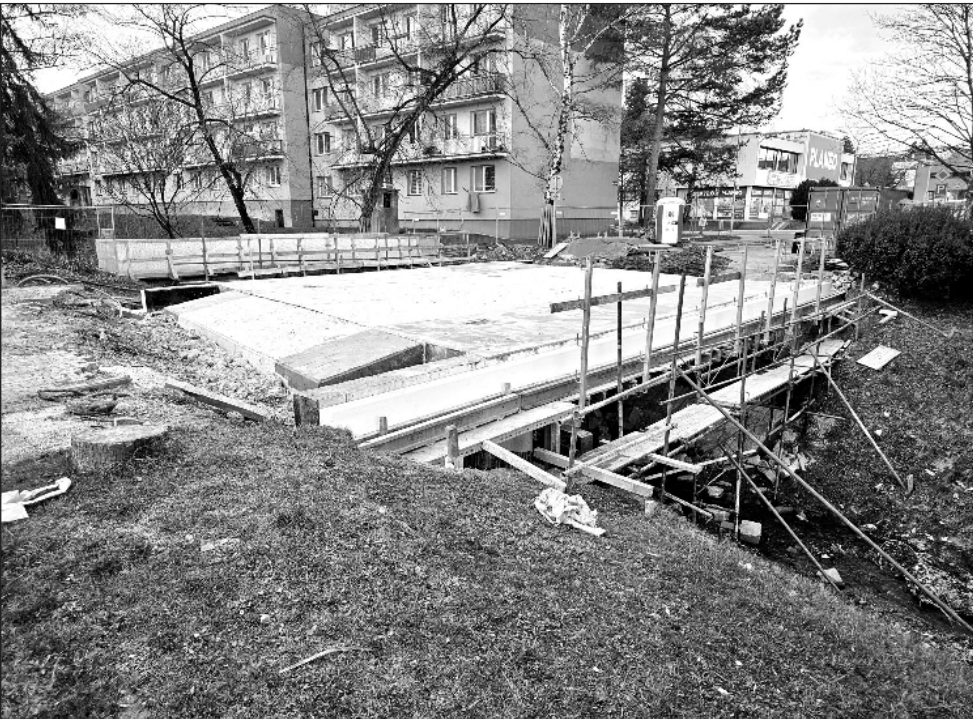
Místo plánované zimní přestávky stavební firma pokračuje v budování mostu přes Kopřivničku na ulici Kpt. Jaroše. FOTO: DAVID MACHÁČEK
