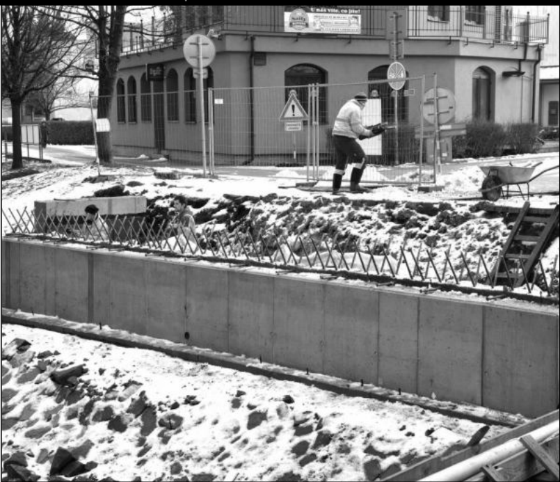
V minulém týdnu byly díky oblevě obnoveny práce na stavbě nového mostu přes Kopřivničku na ulici Kpt. Jaroše.
