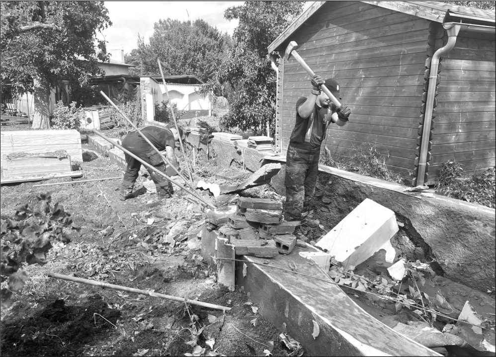
Kopřivničtí dobrovolní hasiči vyjeli v uplynulém týdnu dvakrát do Opavy, kde pomáhali nejen s čerpáním vody, ale i se základním úklidem po povodni. FOTO: JS DH KOPŘIVNICE
