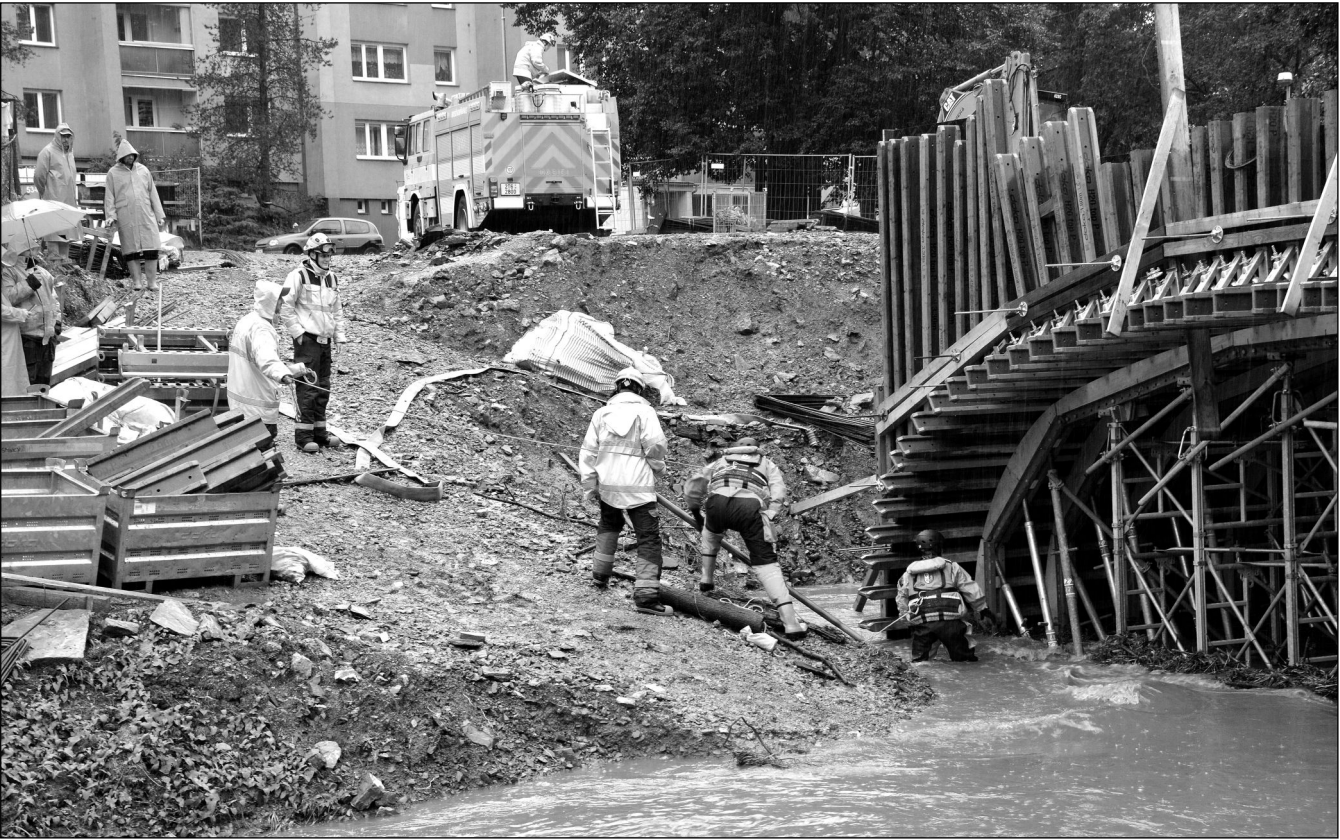
Mezi víkendové zásahy kopřivnických dobrovolných hasičů patřilo i uvolnění průtoku pod konstrukcí, která držela čerstvě vybetonovaný oblouk nového mostu na ulici Erbenově.
