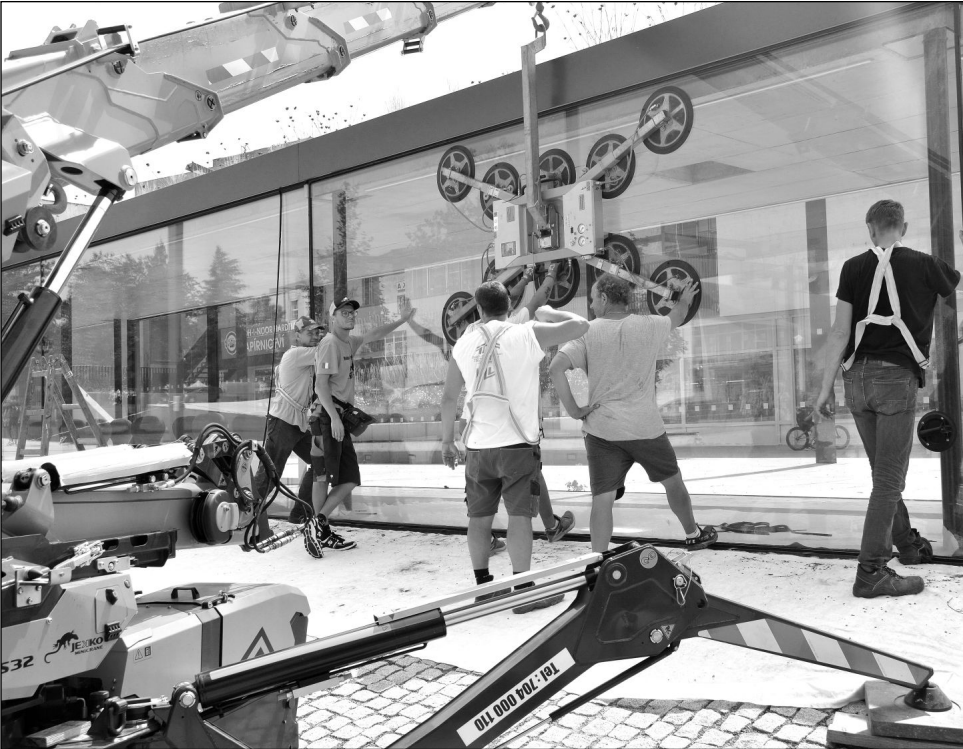
Devátého července byla za pomoci speciální techniky instalována nová prosklená stěna vstavního pavilonu. Ta původní nevydržela tlaky při sesedání objektu. FOTO: D. MACHÁČEK
