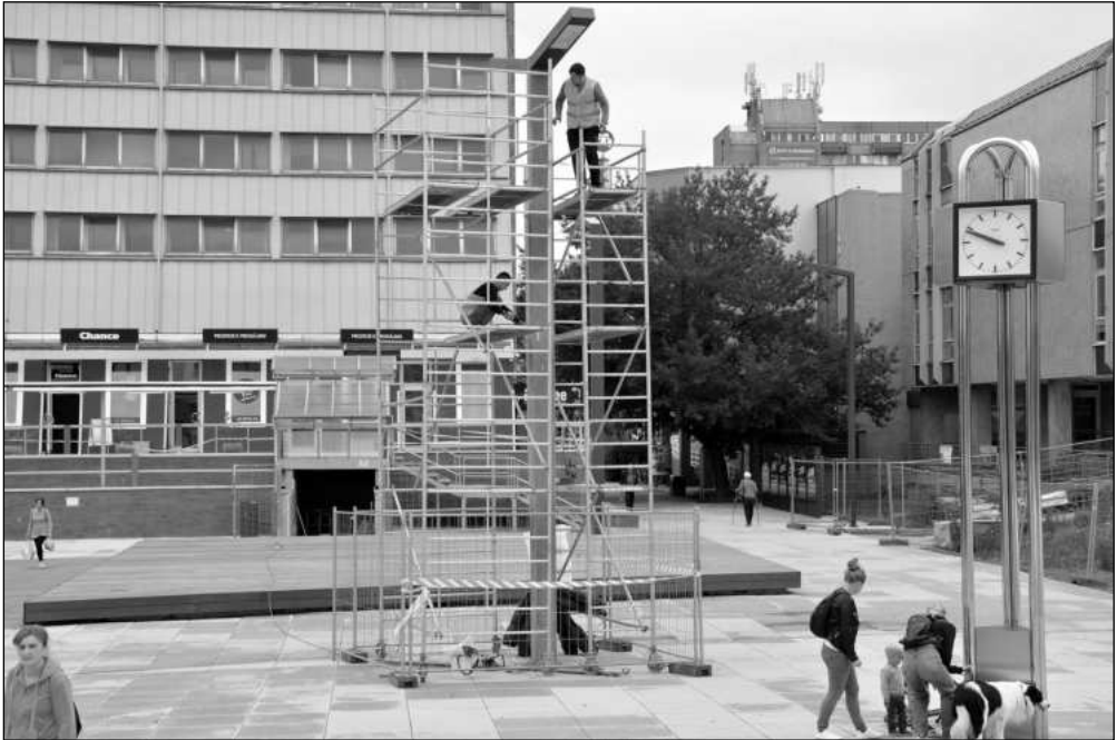
Práce na opravách dílčích částí revitalizace centra pokračují. Jednou z činností je například opětovný nátěr sloupů pouličního osvětlení. FOTO: DAVID MACHÁČEK
