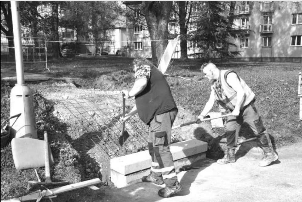
V tomto týdnu pracovali zaměstnanci Slumeka na schodišti na ulici Javorové. Do konce května má být hotova oprava sedmi vybraných schodišť po celém městě.
