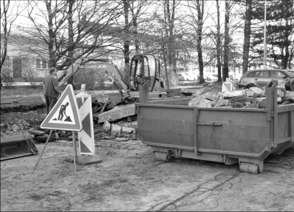
V prostoru před budovou radnice byl v minulém týdnu zbourán zanedbaný betonový květník s dřevinami.
