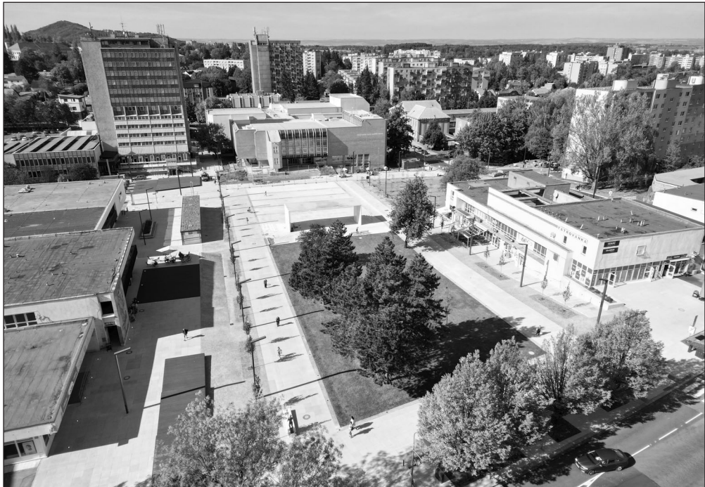
Pohled na zrekonstruované centrum Kopřivnice.
