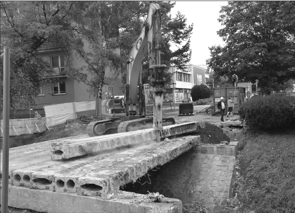
Po rozhodnutí o změně technologie, která bude využita při rekonstrukci mostu na ulici Kpt. Jaroše, začala demolice původních, nevyhovujících konstrukcí mostu. FOTO: DAVID MACHÁČEK
